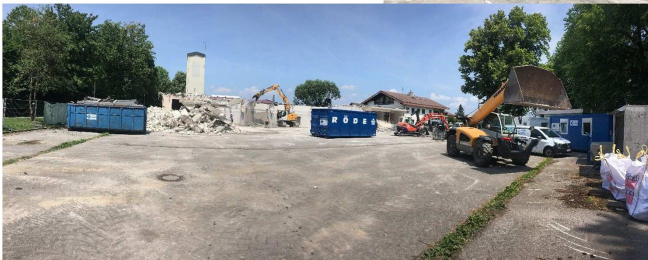
Abbruch der Fahrzeughalle aus Stahlbetonfertigteilen mittels Hydraulikbagger mit Pulverisierer und Abbruchhammer. Vorkleinerung des anfallenden Betonabbruchs zur Beprobung und späteren Aufbereitung zu Recyclingmaterial. Abfuhr und Entsorgung aller anfallenden Abfallchargen durch den eigenen Containerdienst.
